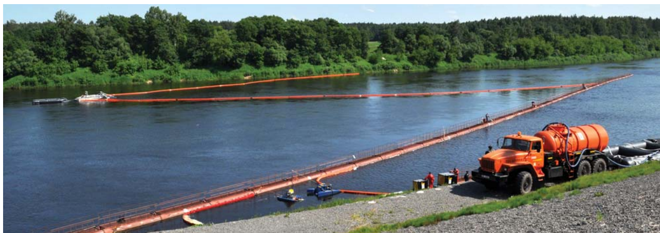
Стационарная площадка (рабочая площадка № 3) с установленными боновыми заграждениями и нефтесборочным оборудованием.
