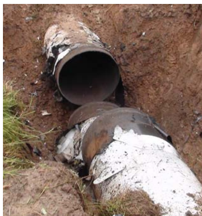
Вырезка «катушки» методом взрыва.
