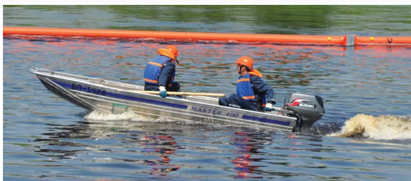
Установка боновых заграждений (рабочая площадка № 2).
