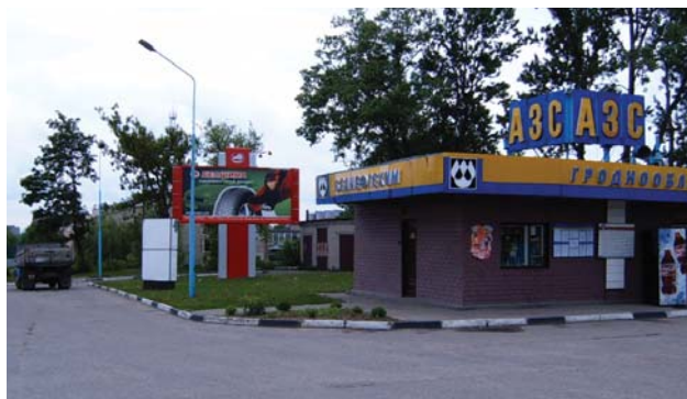
АЗС № 1 до реконструкции.
