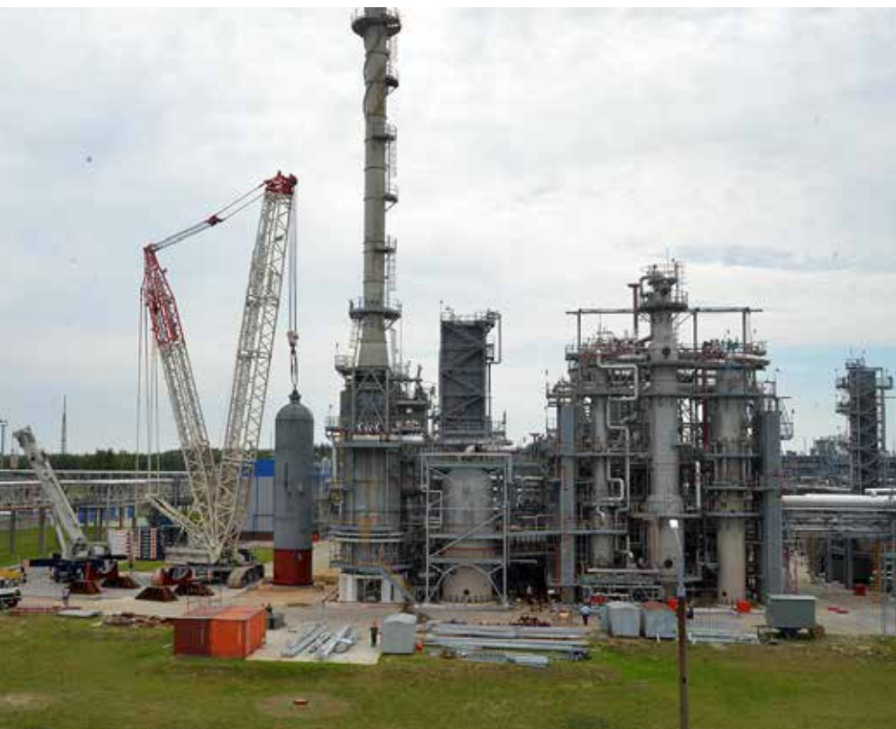
Модернизация установки гидроочистки дизельного топлива ОАО «Мозырьский НПЗ» под процесс депарафинизации.
