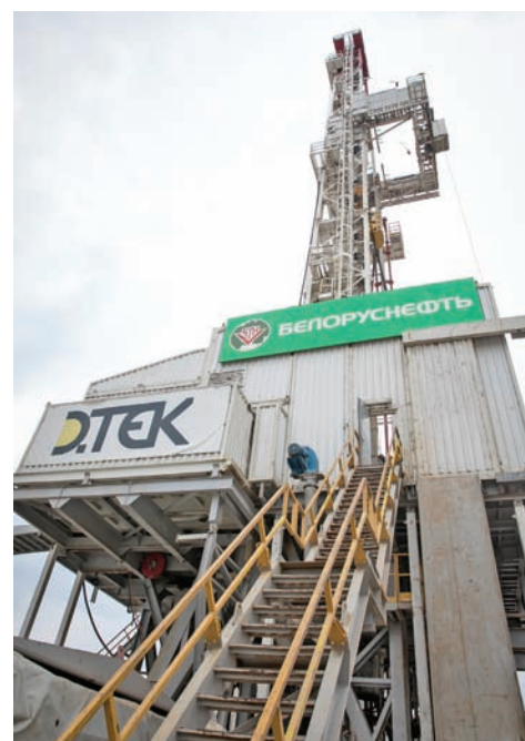
Скважина № 72 на Семиренковском газоконденсатном месторождении в Украине
