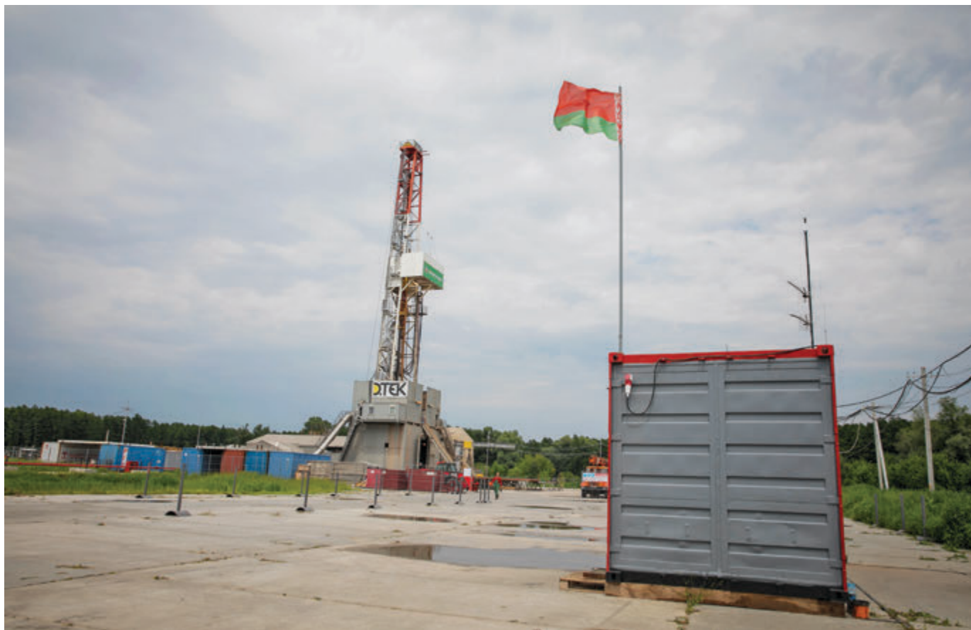
Буровой станок Светлогорского управления буровых работ на скважине № 43 Семиренковской площади
