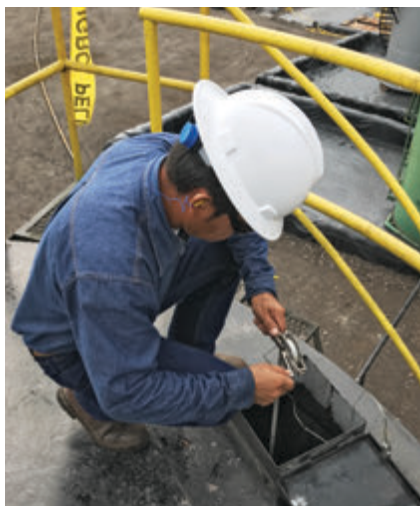
Оператор компании «Петроамазонас» в процессе замера уровня нефти в резервуаре
