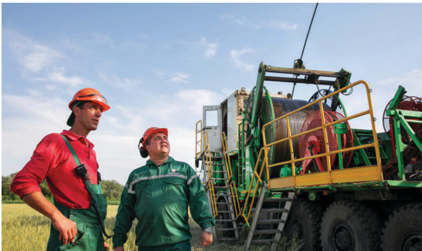
Специалисты Управления по повышению нефтеотдачи пластов и ремонту скважин выполняют операции по промывке и освоению скважин с помощью колтюбинга
