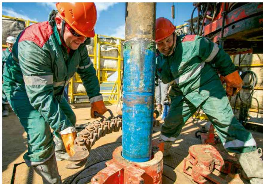
«Белоруснефть-Сибирь», спуск колонны
