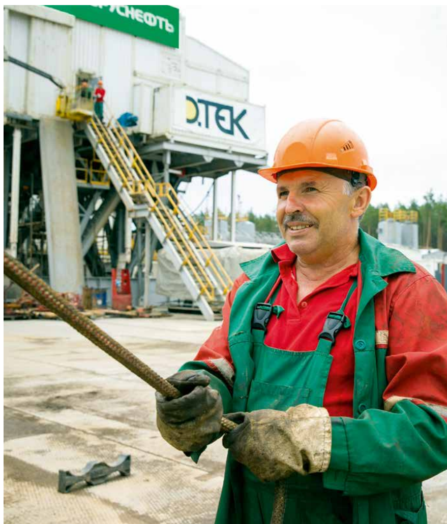
Александр Скворцов (ВМУ) на монтаже станка Drillmec в Украине
