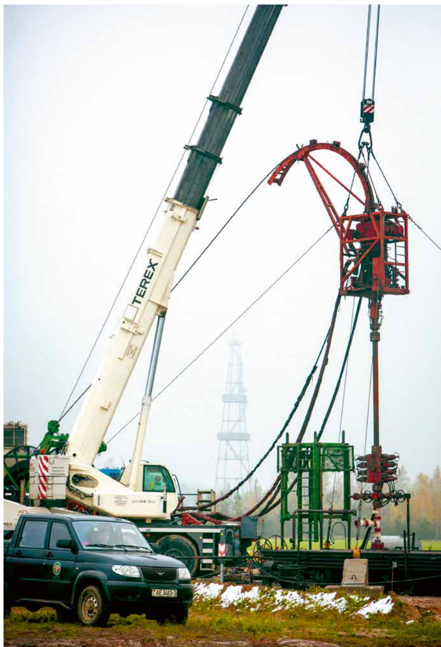
УПНПРС, монтаж колтюбингового оборудования
