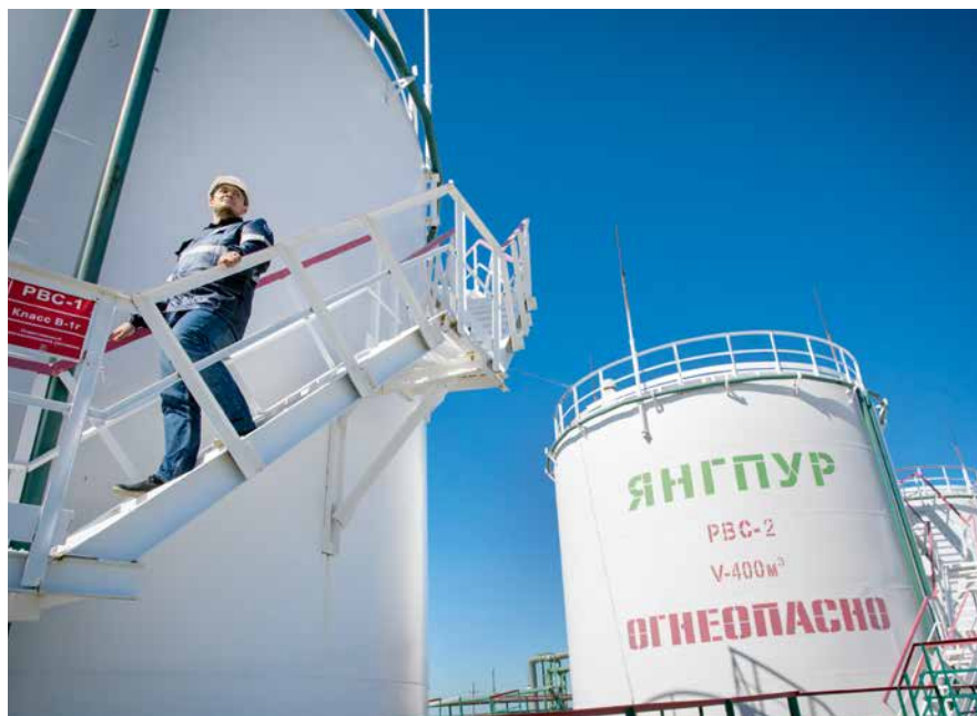
Объекты установки подготовки и перекачки нефти НК «Янгпур»
