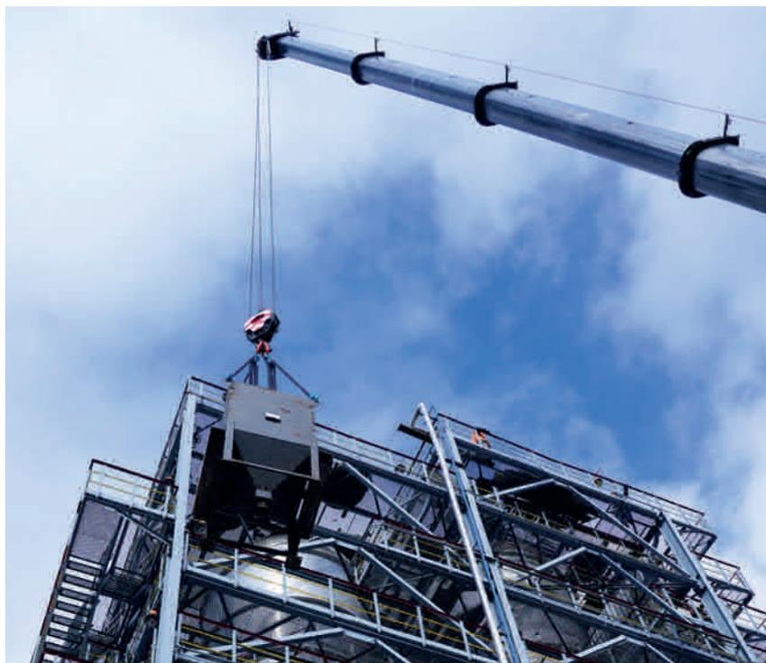
**Подъем бункера с катализатором на реактор R-501**
